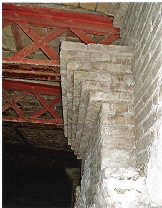
Refuerzos de ladrillo junto a los muros para reforzar los apoyos de las jácenas. Foto del autor.
