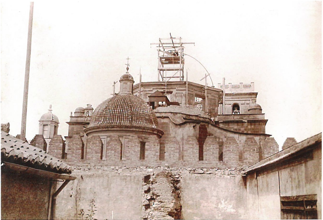
Vista del montaje de la nueva cúpula desde la Torre de la Calahorra. Foto cedida por Antonio Serrano Bru
