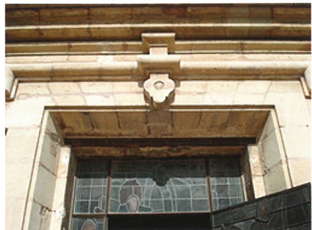
Una de las ocho ventanas del tambor donde se aprecia la barra de hierro puesta por Coquillat para soportar el gran peso del arquitrabe. Foto del autor.
