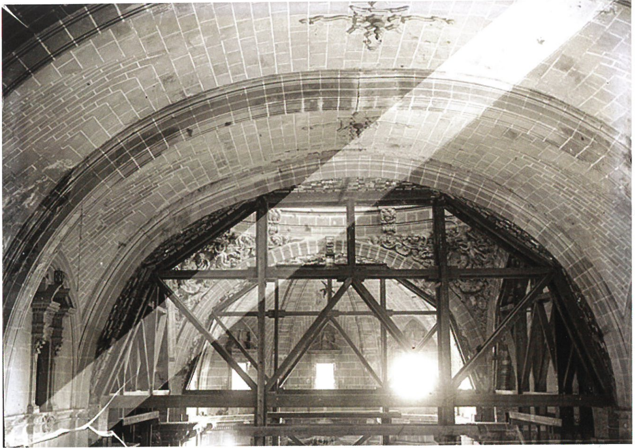
Vista de las cimbras desde la nave central. Foto de Pedro Ibarra cedida por Antonio Serrano Bru
