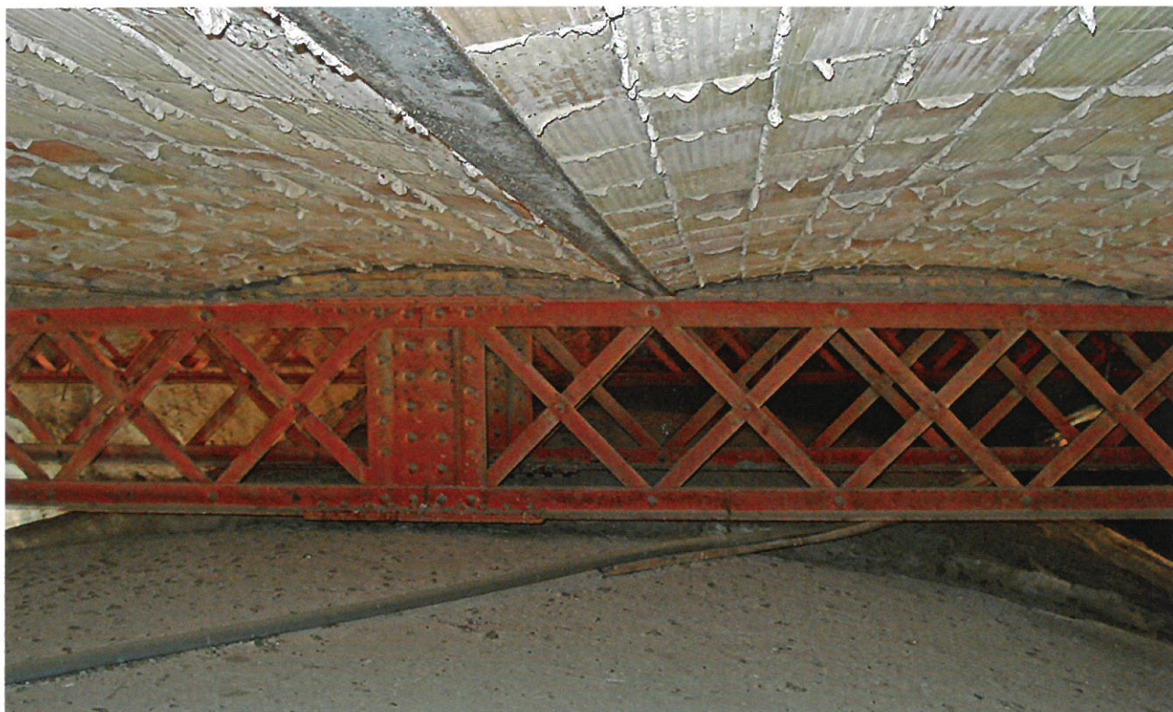
Aspecto actual de las jácenas. Se puede ver cómo todavía ejercen la función de soporte del terrado de la nave central. Foto del autor
