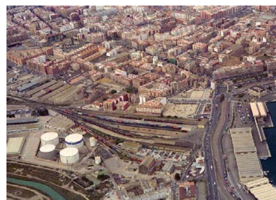
Estación de Mercancías del Puerto
