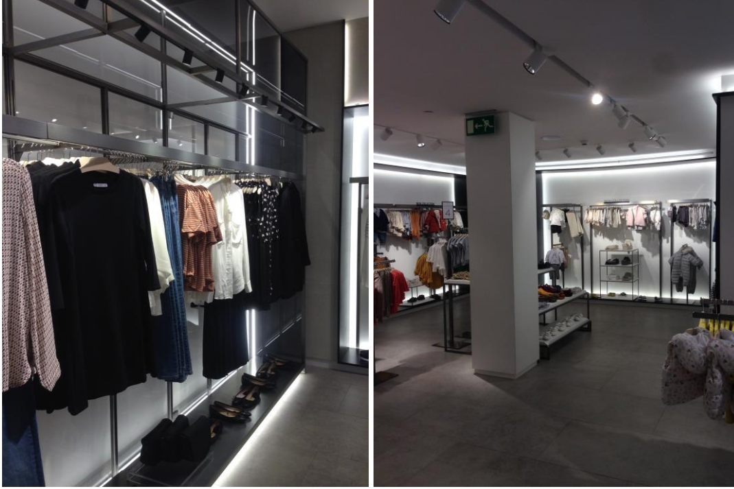
227, 228. Iluminación con tiras led en muebles y cornisas en la tienda MANGO de Valencia.
