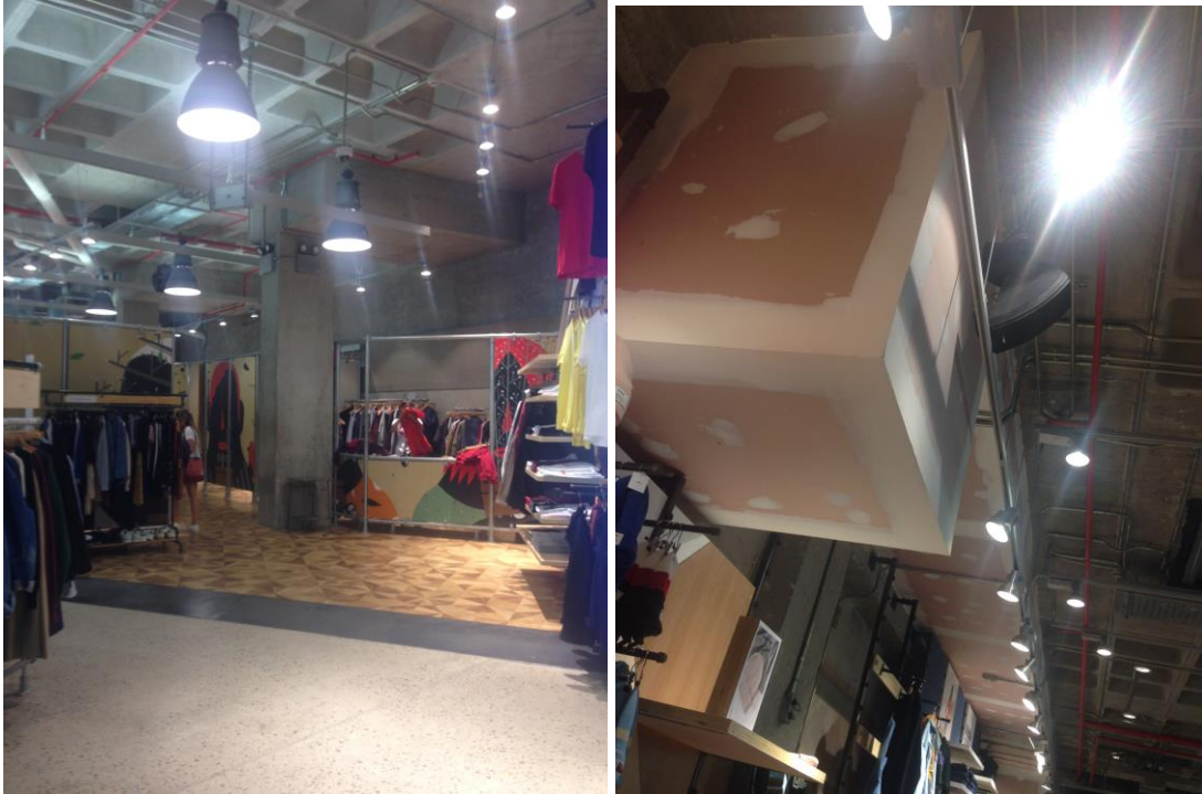
304, 305. Interior de Urban Outfitters Barcelona, donde se evidencia el estado de las instalaciones y de los acabados.
