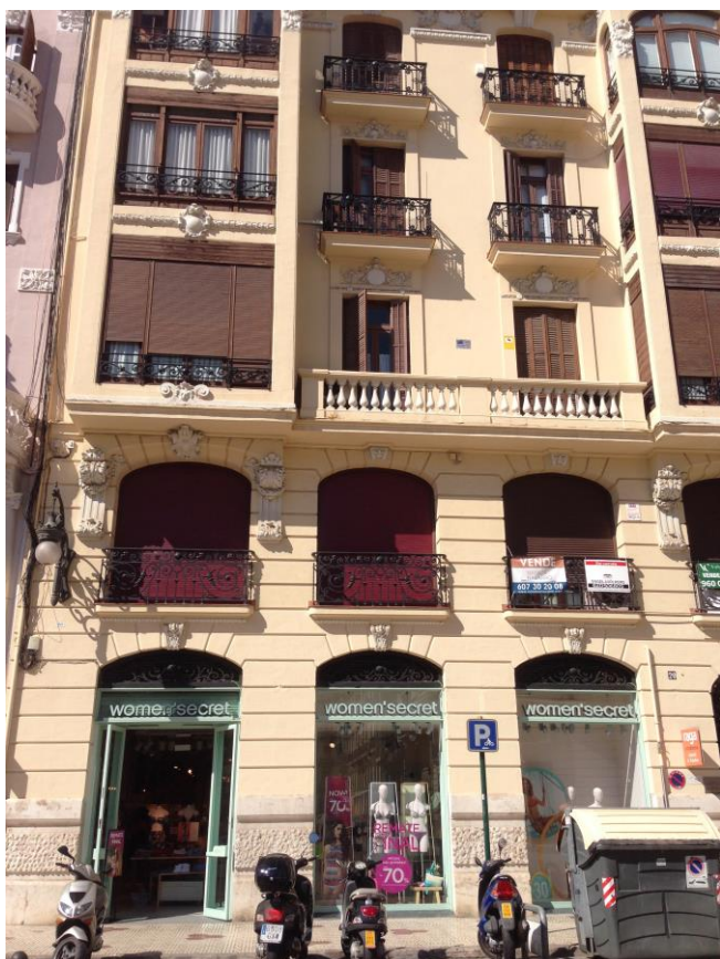
265. Edificio donde se ubica Women´secret en la calle Jorge Juan de Valencia.
