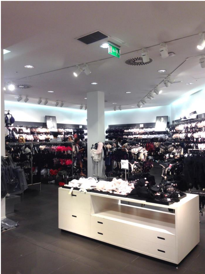
156. Sistemas de iluminación con focos orientados hacia las paredes.
