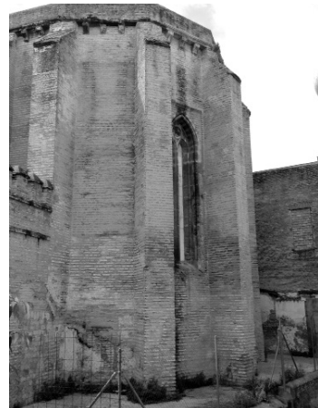
Figura 34. Contrafuertes del ábside
