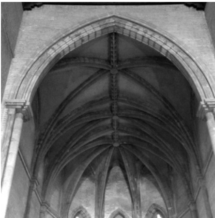
Figura 33. Cubierta del ábside
