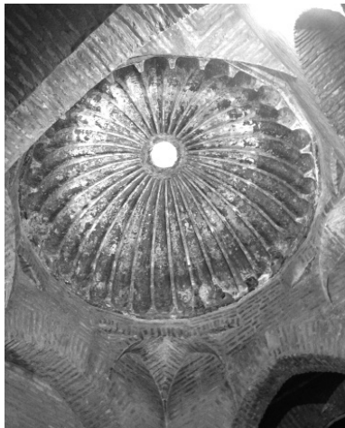
Figura 13. Bóveda en capilla del Santísimo
