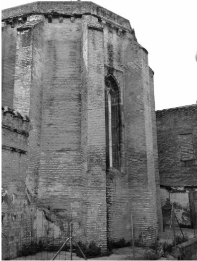
Figura 8. Contrafuertes exteriores
