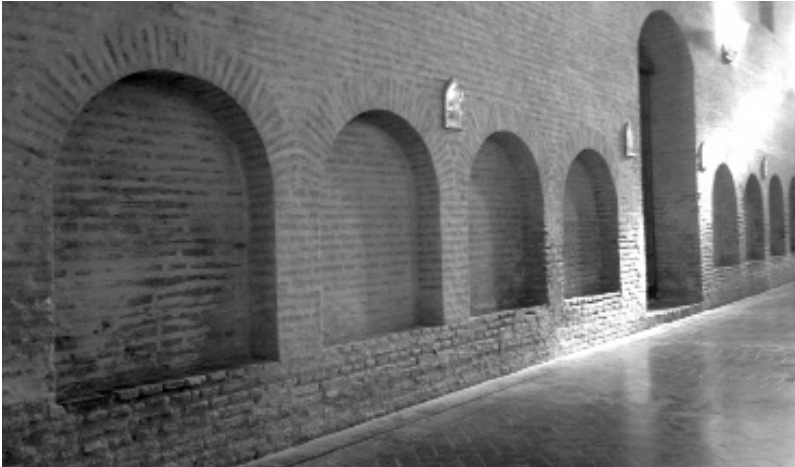
Figura 29. Hornacinas en nave de la Epístola
