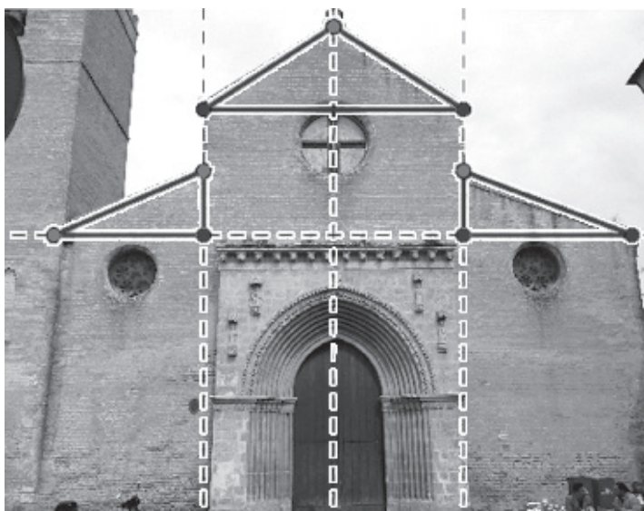
Figura 19. Inclinación de las cubiertas
