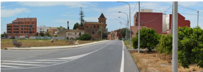
Frente urbano Benifaraig Norte. CVC_200m
