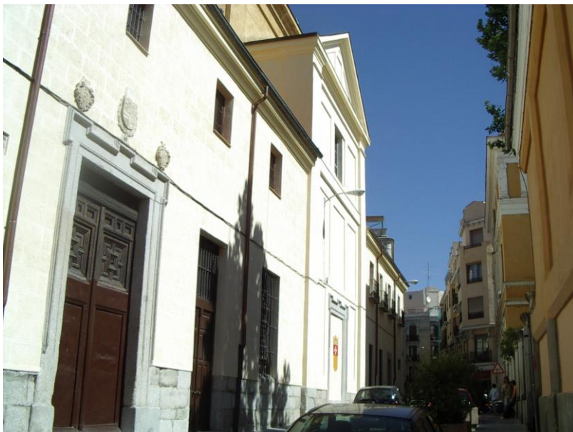
Figura 6. Vista de la fachada principal (fotografía del autor)
