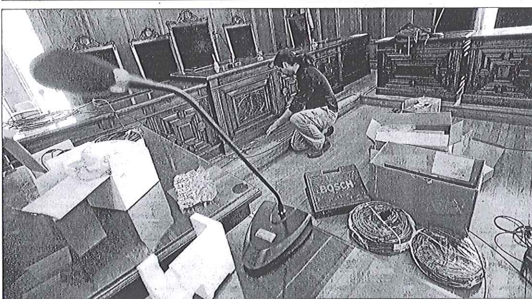
Un técnico cambia el sistema de cableado de una sala de vistas de la Audiencia para instalar el equipo ayer. PILAR CORTÉS
