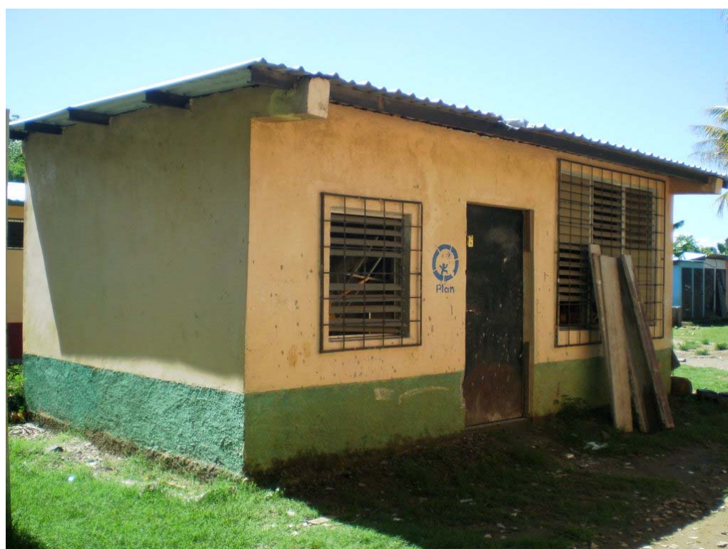
Exterior de una de las aulas que existían antes de la intervención.
