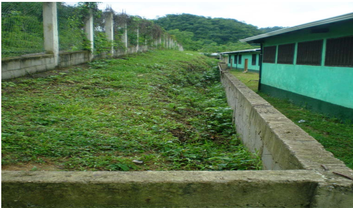
Muro de contención de la zona más alta en buen estado.
