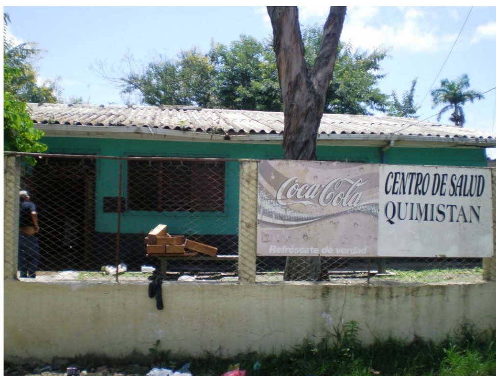
Exterior del anterior centro de salud, ahora en proceso de rehabilitación para destinarlo a archivos y gestión de la nueva CLIPER.
