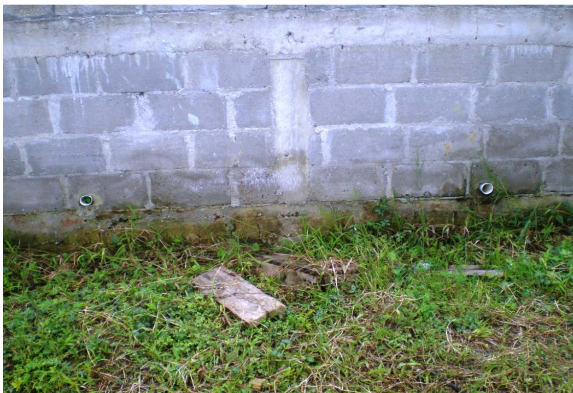
Detalle de los tubos filtrantes de agua a instalar en la base de los muros que no los tienen.
