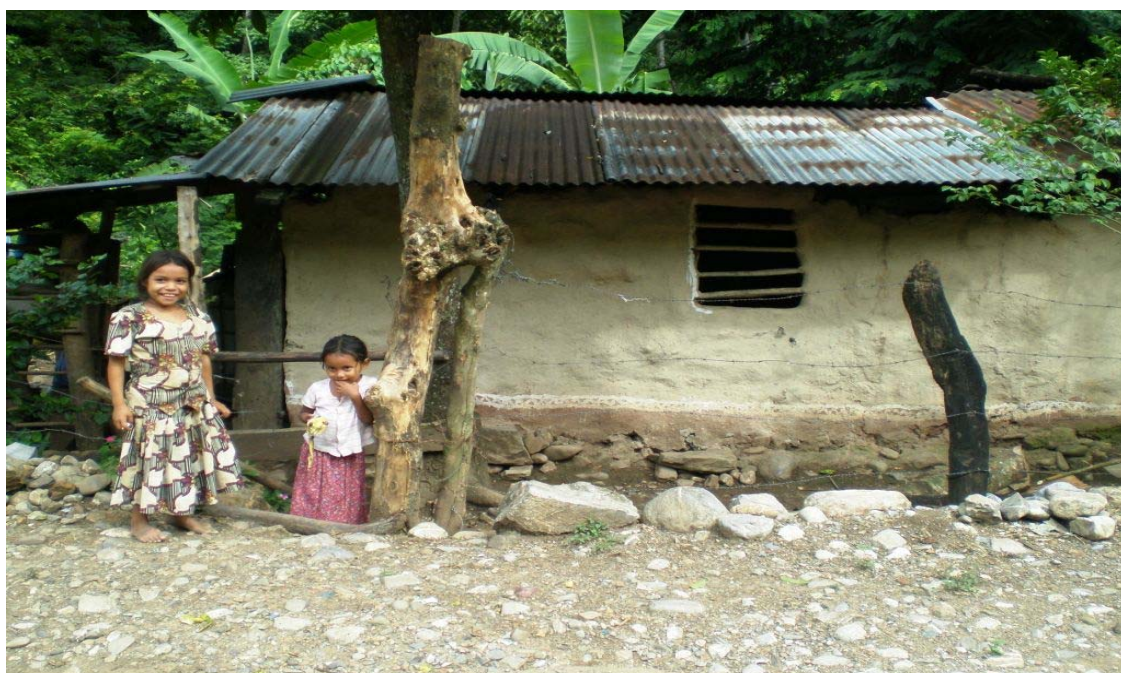
Exterior de la vivienda habitual antes de la intervención (La Ceibita).
