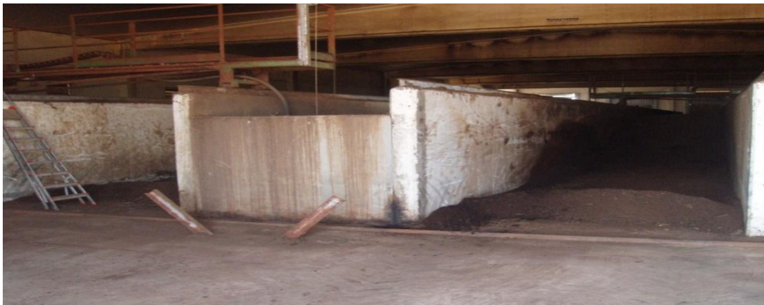
Figura 28. Túneles de fermentación y canal de riego central.
