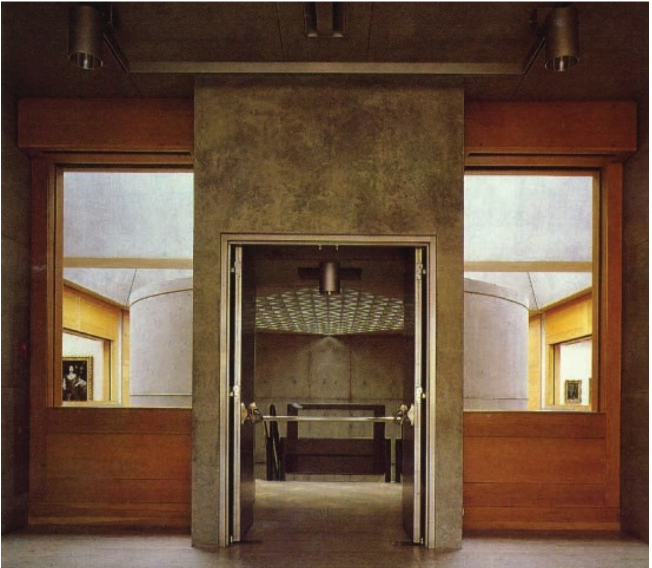
Louis I. Kahn, Centro de Arte Británico de Yale . New Haven, 1969-74. Acceso a la escalera dentro de la columna hueca.
