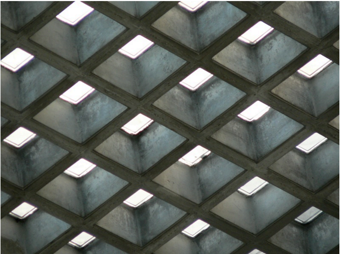
Giuseppe Terragni, Casa del Fascio . Como, 1932-36. Cubierta del patio central.
