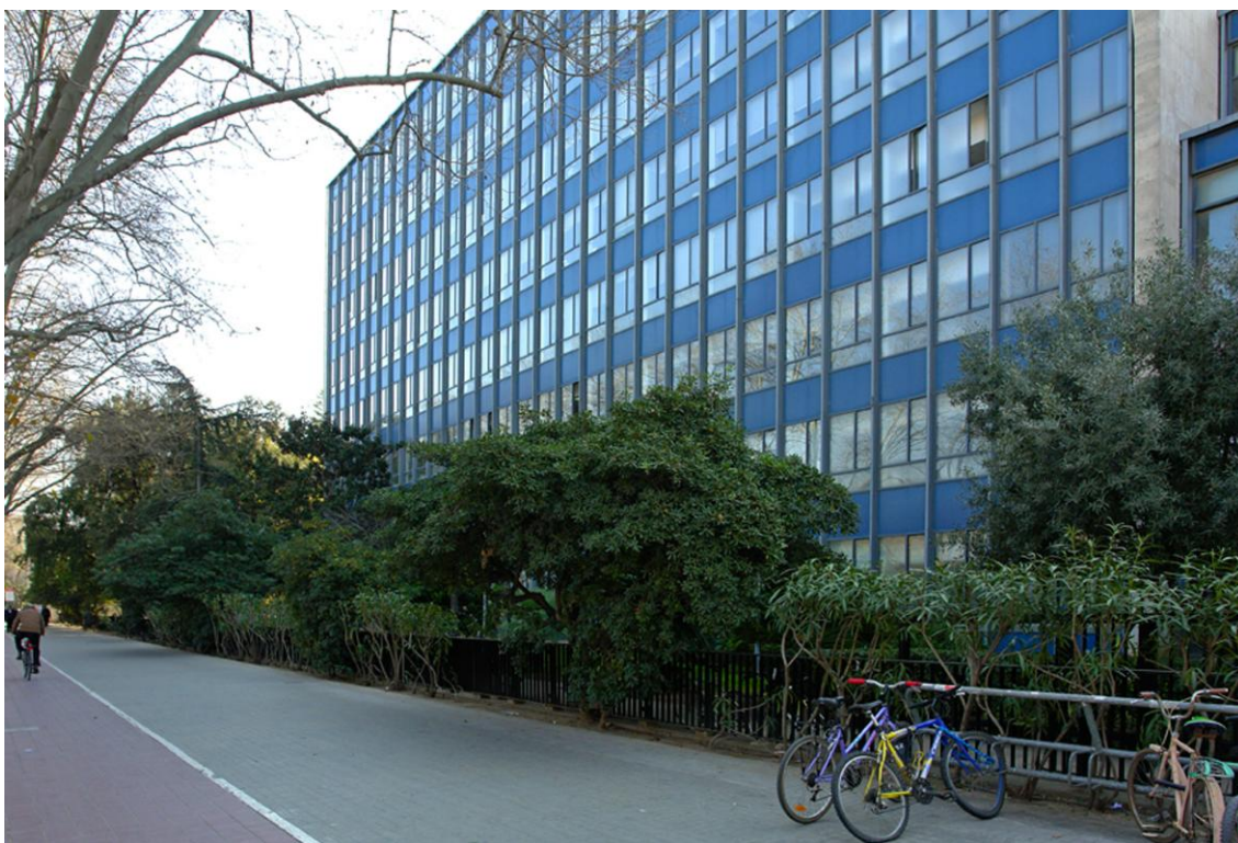
Antigua Facultad de Filosofía y Letras (1960-1970), obra del arquitecto Fernando Moreno Barberá. TAJD
