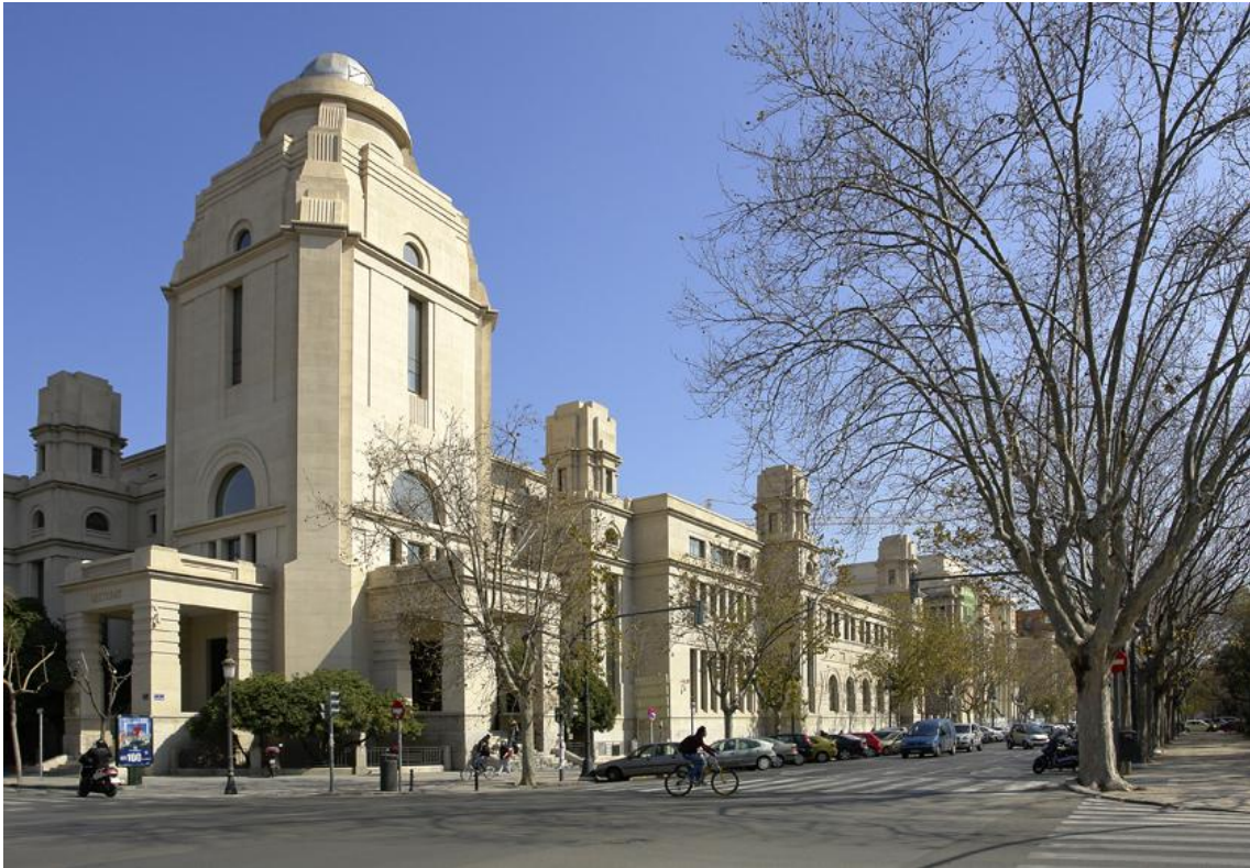
Antigua Facultad de Ciencias (1908-1944) al comienzo del Paseo. Obra de los arquitectos José Luis Oriol Urigüen (proyecto inicial) y de Mariano Peset Aleixandre, que fue quien la finalizó tras la guerra civil y a quien debe su expresionismo de clara influencia alemana (Der Ring). TAJD
