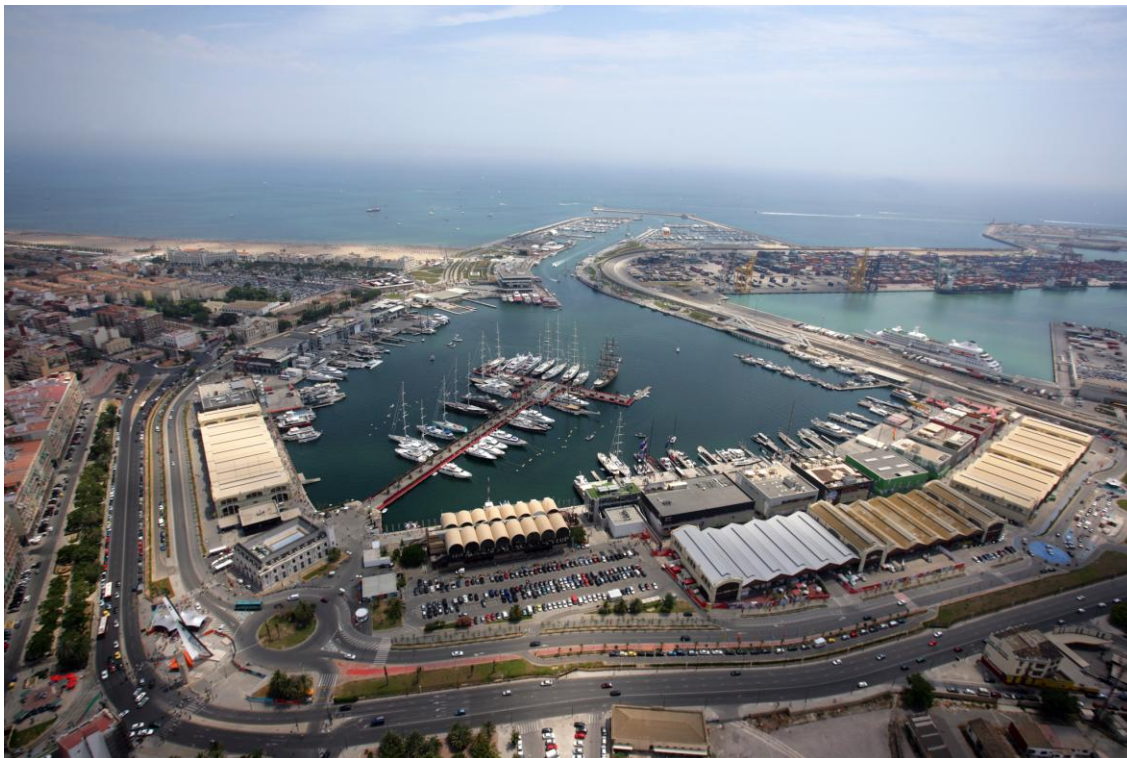
Vista aérea de la Marina Real de Juan Carlos I. JMT
