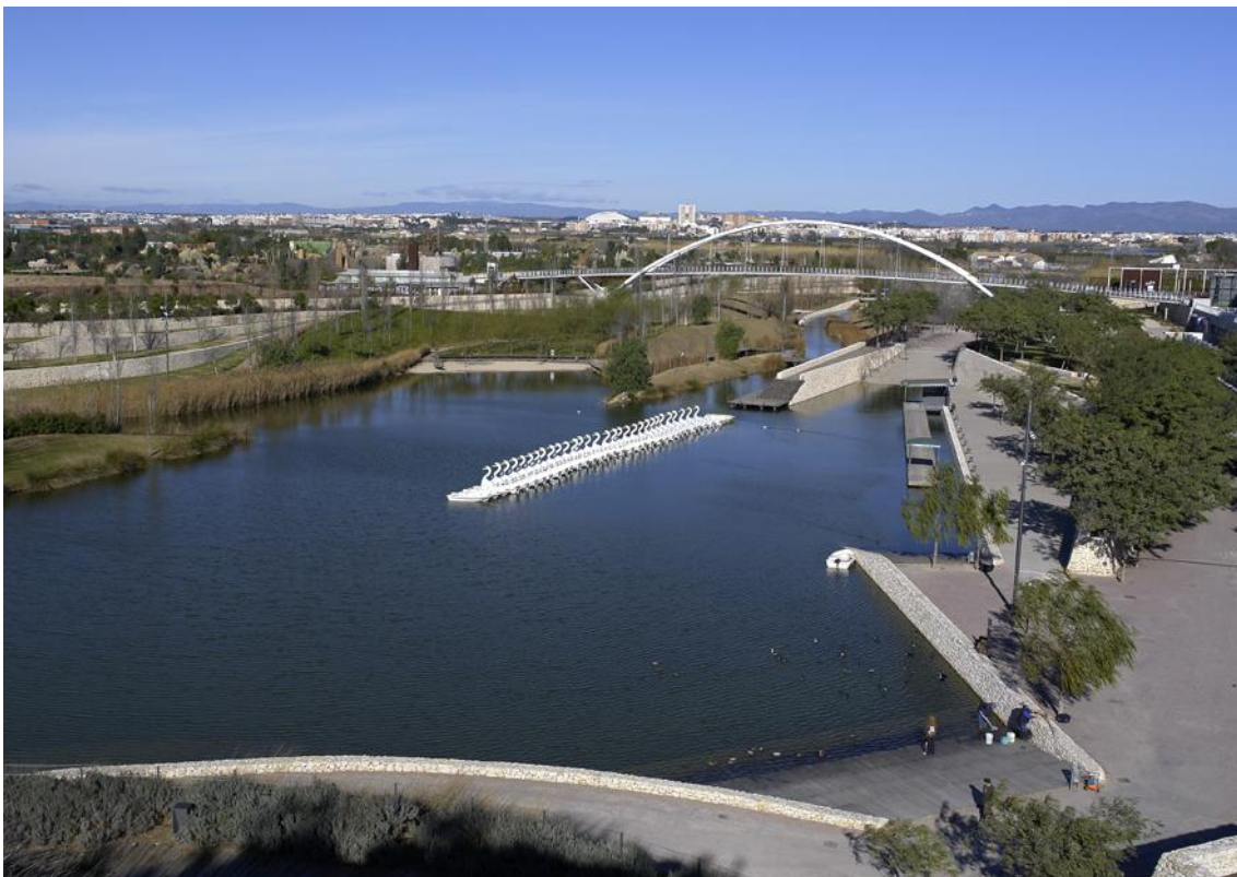
El parque de Cabecera (2001-2004) de los arquitectos Arancha Muñoz Criado, Eduardo de Miguel Arbones y Vicente Corell Farinós.TAJD
