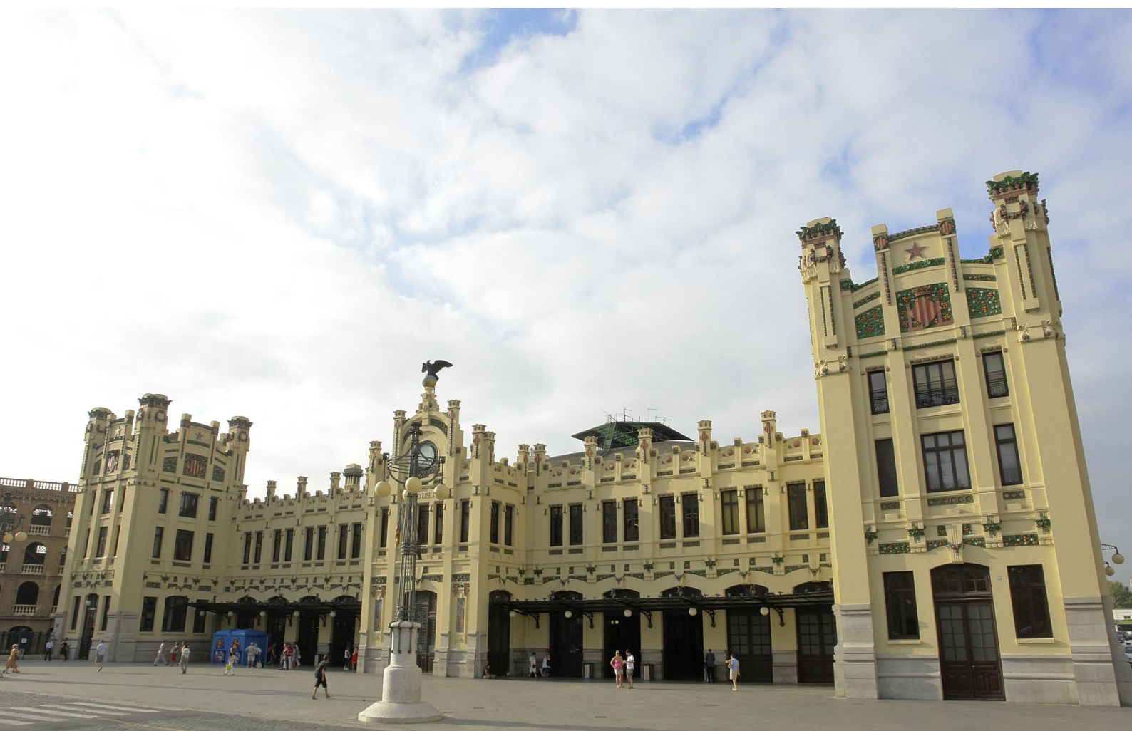
L'Estació del Nord des del carrer Xàtiva. TAJD
