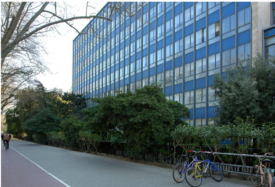
Facultat de Filosofia i Lletres (1960-1970), obra de l'arquitecte Fernando Moreno Barberá. TAJD
