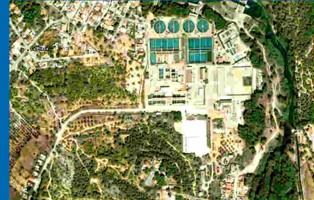
ETAP LA PRESA
