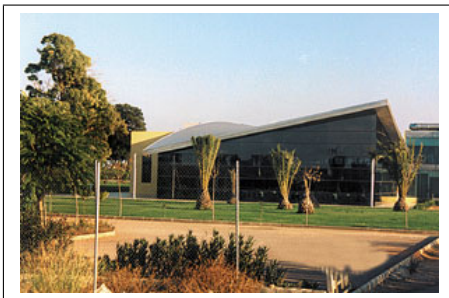
(a) Restaurante de las Alquerías (Plana Baja).
