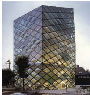
Herzog y de Meuron. Edificio Prada , Aoyama, Tokio, 2000-2003
