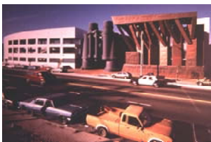
[ fig. 5 ]. Las dificultades del collage en arquitectura. Frank Gerhy, Edificio Chiat, Los Angeles, 1975-1991
