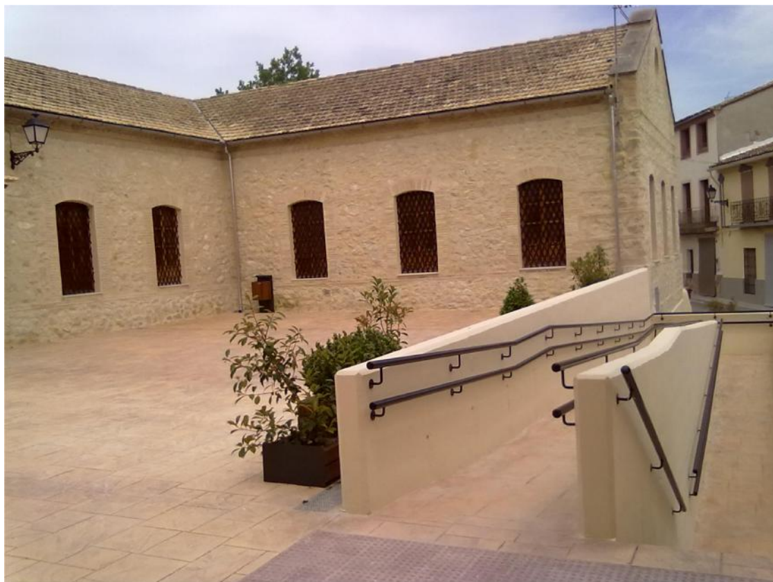
Parte sur del actual edificio rehabilitado y acceso para minusválidos
