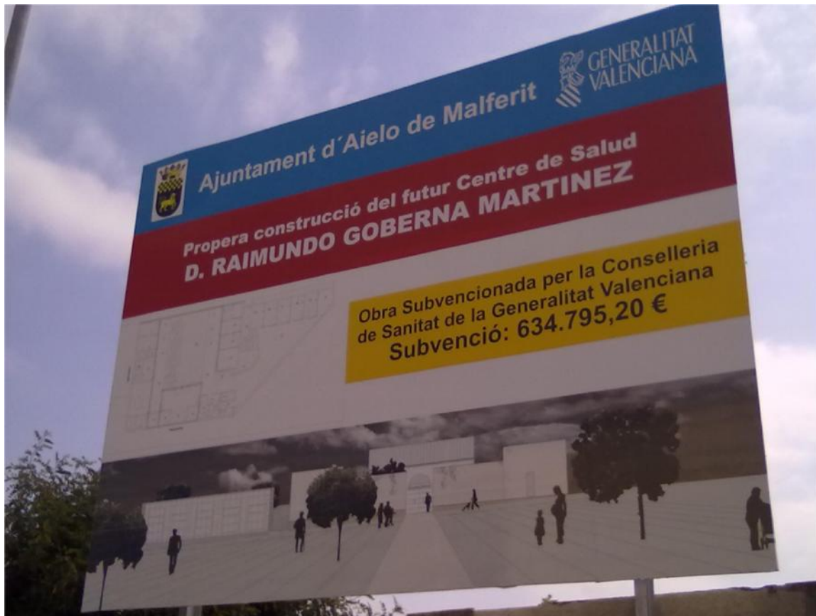
Cartel que anuncia la próxima construcción del nuevo consultorio
