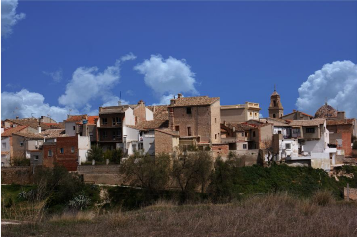
Casas construidas alrededor del Palacio de Malferit.
