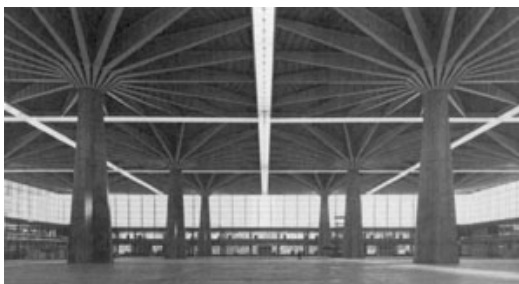
Fig.15 Edificio del Palacio del Trabajo de Nervi en Turin (1960)
