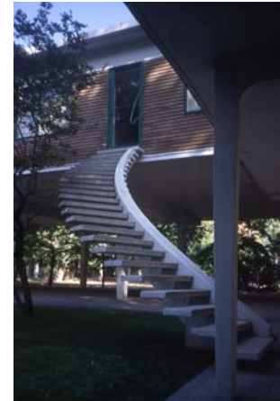
Escalera de acceso al pabellón de hermanos legos en la Residencia de los PP.Dominicos 1954. Arquitecto: M.Fisac.
