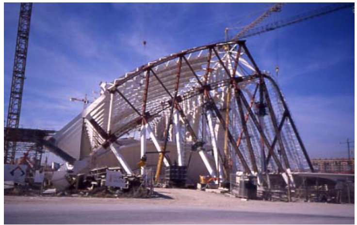
Fig.28 Museo de las Ciencias de S.Calatrava en Valencia(1998). El edificio del Museo de las Artes y de las Ciencias en Valencia de Santiago Calatrava, elude hábilmente la diferenciación constructiva del tipo general de fachada mayor con respecto a la transversal a la manera de los grandes invernaderos metálicos del siglo XIX, como intersección espacial de una esquina.
