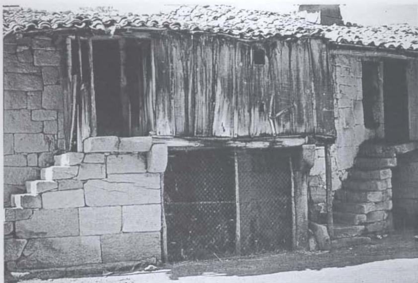
Fig. 10. Casa en Guntín (concejo de Cualedro). La parte baja del corredor convertida en gallinero y la parte superior incorporada al espacio interior de la vivienda. Fábrica de sillarejo, con losas y ménsulas de piedra como apoyo del corredor.
