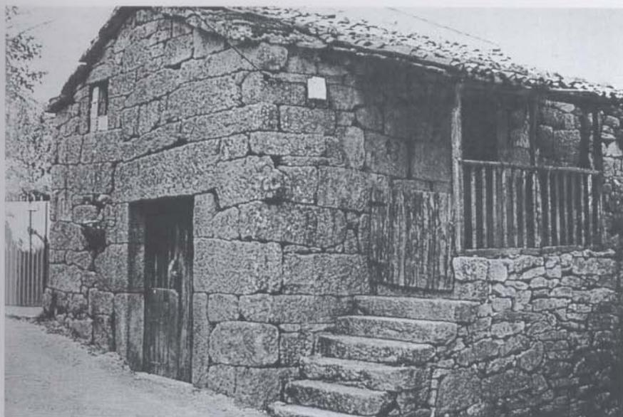
Fig. 4. Casa en San Cristóbal (concejo de Monterrei). Escalera de peldaños monolíticos apoyados sobre fábrica de mampostería y sencilla galería de madera con pequeñas zapatas entre los pies derechos y la carrera superior.
