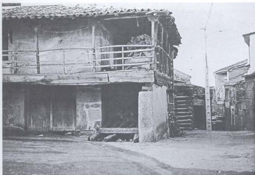
Fig. 11. Casa en San Cristóbal, fechada en 1798, con la parte superior de los pies derechos moldurados, con zapatas decoradas y restos de pintura marrón.
