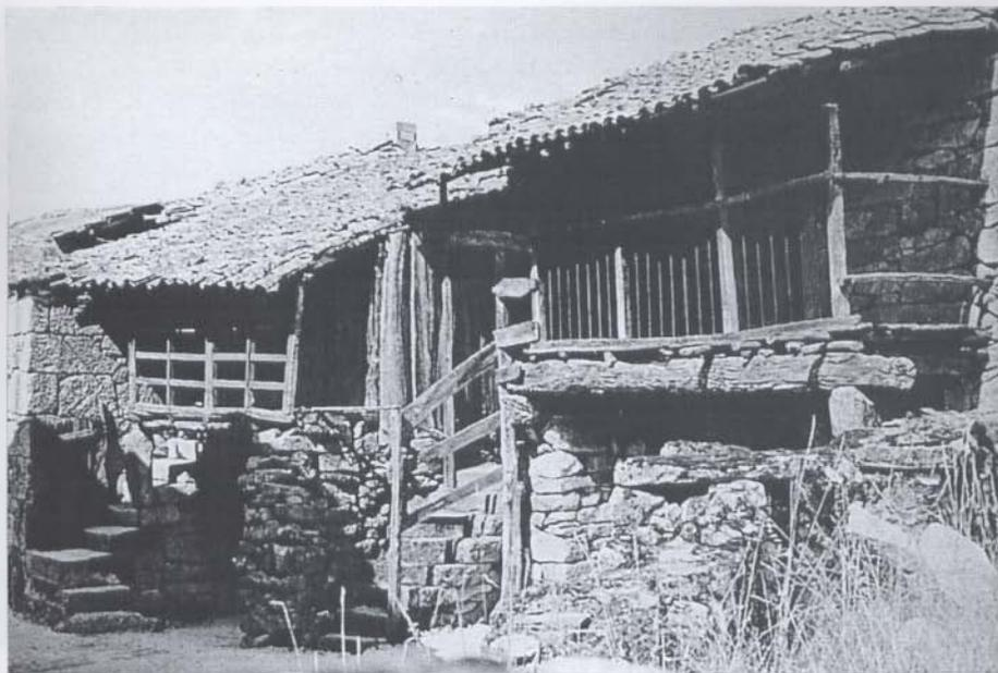
Fig. 6. Calle en Medeiros con distintos ejemplos de escaleras de piedra y entramados de madera.
