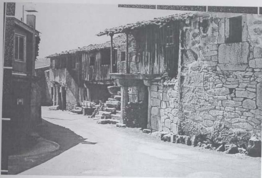
Fig. 17. Calle en Vilar con varios corredores con diferentes cerramientos pintados como la casa de la plaza. El suelo del corredor en estos casos es de losas de piedra molduradas, apoyadas sobre grandes merlones y pilares de planta poligonal.
