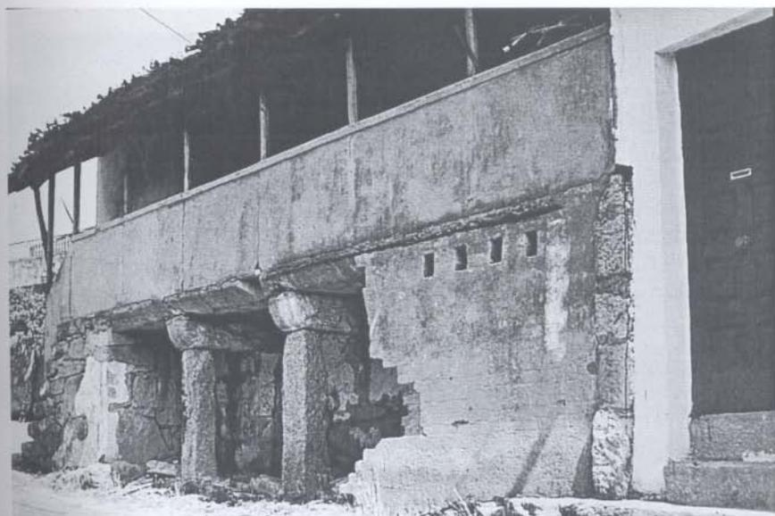
Fig. 13. Casa en Medeiros con la parte baja del entramado de madera cegado con un murete de ladrillo revestido de cemento.
