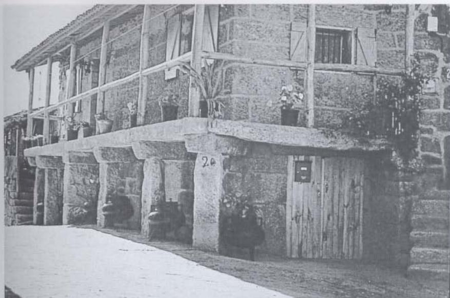
Fig. 12. Casa fechada en 1840, remozada recientemente, en Flariz (concejo de Monterrei), con corredor en dos flancos de la fachada con suelo apoyado sobre fuertes ménsulas y pilares de granito.
