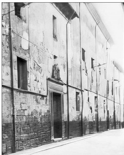
Fig. 5. Fachada del antiguo convento de Corpus Christi de Vila-real.
