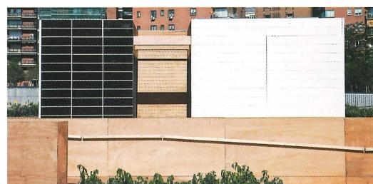
El prototipo SML se construye mediante la adición de un módulo prefabricado (espacio habitable mínimo). Esto permite generar distintos tamaños de vivienda según las necesidades requeridas.
