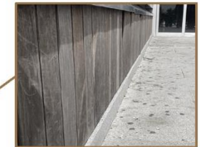
Limpiar de colillas la entrada de la pasarela
