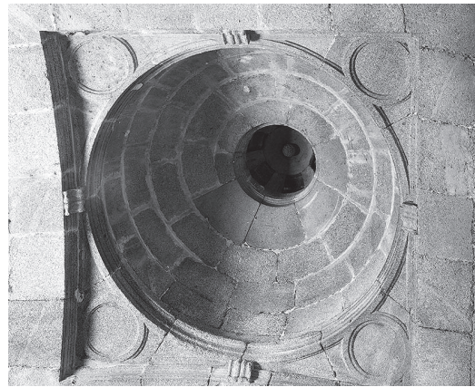
Figura 12 Cupulín con despiece helicoidal
