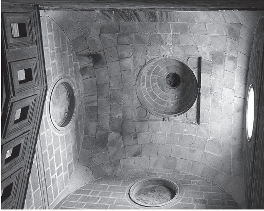
Figura 10 Bóveda cubriendo escalera volada
