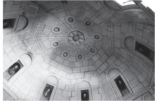
Figura 6 Sacristía. Bóveda ochavada
