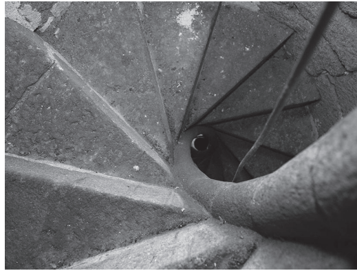
Figura 14 Caracol de subida a cubierta
