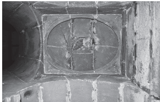
Figura 15 Bóveda oval en arcos torales
