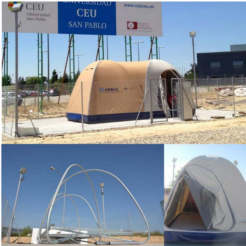
Figura 2. Vivienda de Emergencia Militar compuesta por dos Unidades Prototipo, estructura metálica, envolventes exterior e interior y faldón perimetral de la Unidad Prototipo desarrollada.
