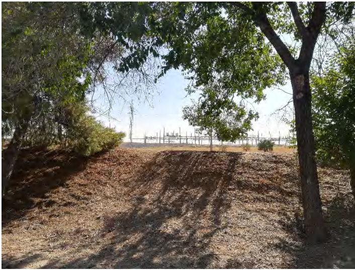
Figura a3.77: Vista este de la subestación eléctrica desde la 'franja verde' junto a la A-4 (fotografía realizada por la autora el 28 de agosto de 2018).
