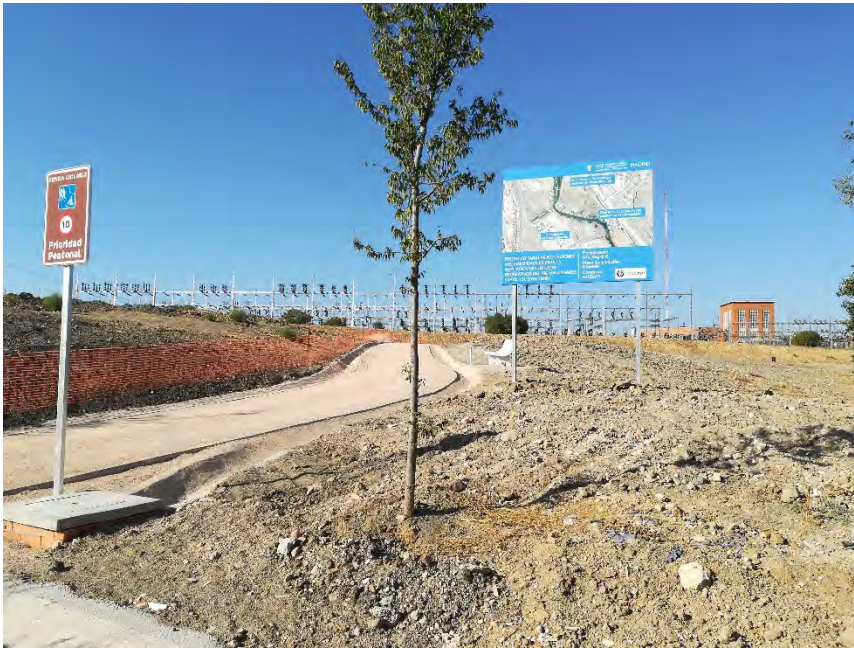
Figura a3.82: vista oeste desde el paseo en la margen derecha del Manzanares. Árboles recién plantados, caminos recién trazados y, al fondo, la subestación eléctrica de Villaverde (fotografías realizadas por la autora el 25 de septiembre de 2018).
