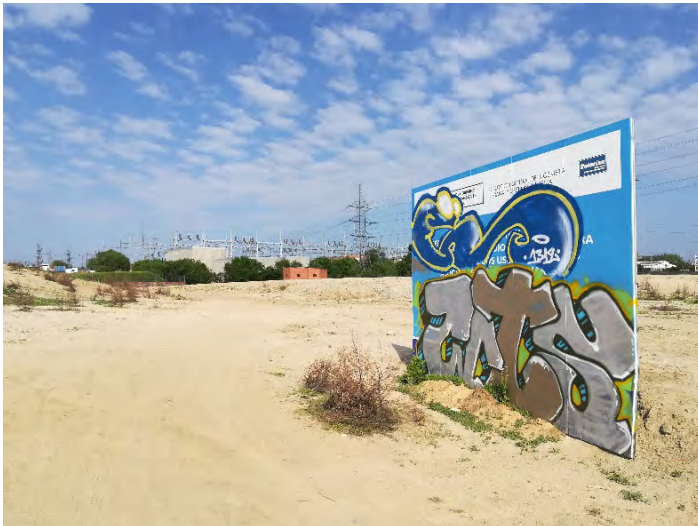
Figura a3.69: Cartel de trabajos del Ayuntamiento de Madrid. Al fondo, la subestación de Villaverde (fotografía realizada por la autora el 10 de mayo de 2018).
