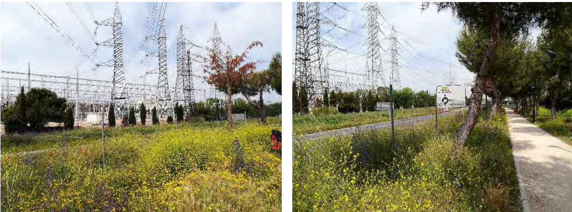
Figura a3.64: Vistas de la subestación desde el Parque Adolfo Suárez, al otro lado de la carretera M-217 (fotografías realizadas por la autora el 23 de mayo de 2018).
