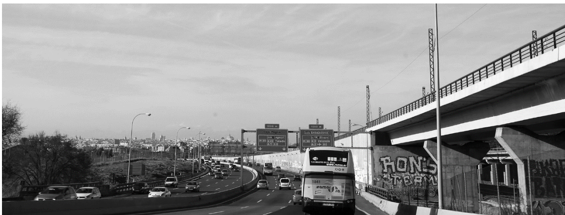
Figura a1.2: Aproximación a Madrid desde el sur, A-4 km.5,8 (fotografía realizada en febrero de 2018 por el G.I. PA&P).
