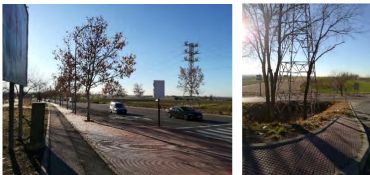
Figura a3.14: Vistas desde la avenida de la Vía Láctea. Las torres eléctricas a lo largo del carril bici y en los ‘huecos’ entre vías (fotografías realizadas por la autora el 19 de diciembre de 2017).
