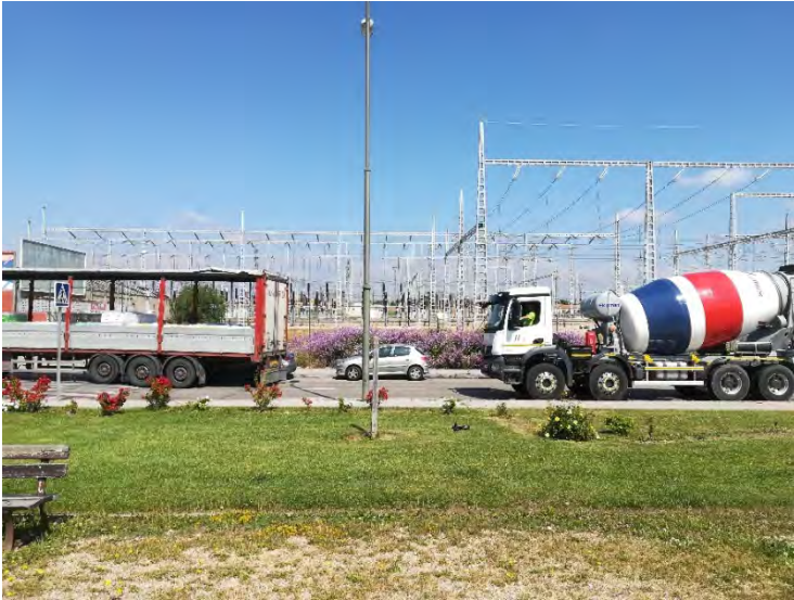
Figura a3.46: Vista de la subestación eléctrica de Coslada desde el bulevar central de la avenida de la Constitución (fotografía realizada por la autora el 22 de mayo de 2018).
