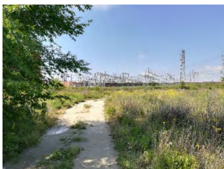
Figura a3.44: Vista de la subestación eléctrica de Coslada desde el descampado al norte (fotografía realizada por la autora el 22 de mayo de 2018).
