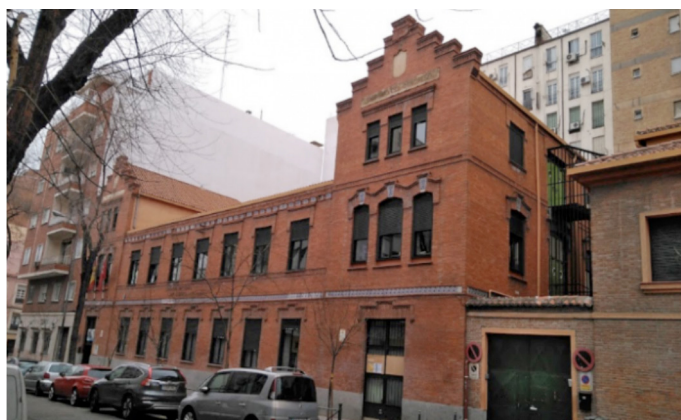
Figura 12. Vista global de la fachada. Imagen actual.
