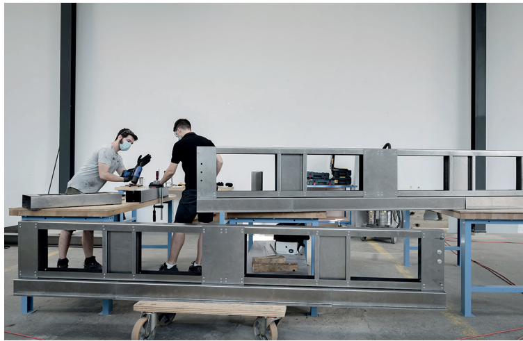
Fig. 59 bis Construcción colectiva del prototipo de la estructura de la Maison Tropicale de Jean Prouvé, Construction Cycles , 2020, Suiza.
