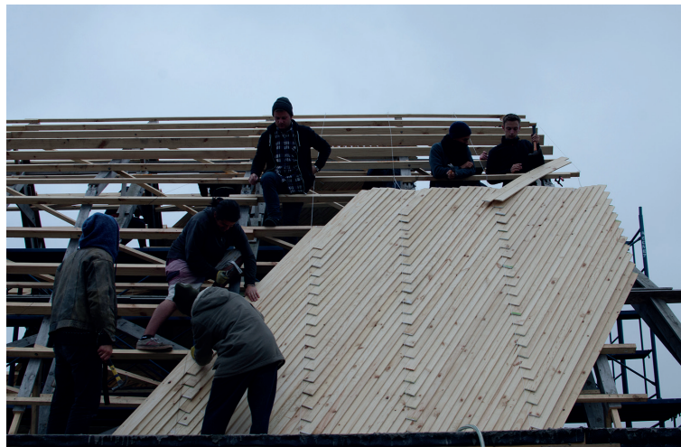
Fig.55 bis Construcción colectiva del recubrimiento de la cubierta, Open City Research Platform 2016, Chile.
