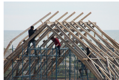
Fig. 57 Construcción colectiva de la estructura secundaria de la cubierta, Open City Research Platform 2015, Chile.
