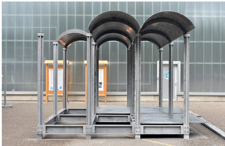
Fig. 250 Pabellón después de cinco semanas de trabajo, A Prototype Pavilion in Textile Reinforced Concrete , 2020, Suiza.
