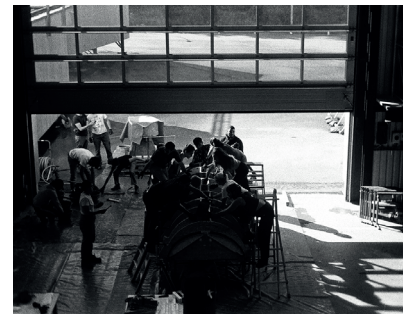
Fig. 222 Hormigonado experimental colectivo para una lámina fina, A Prototype Pavilion in Textile Reinforced Concrete , 2022, Suiza.
