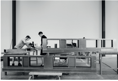
Fig. 59 Construcción colectiva del prototipo de la estructura de la Maison Tropicale de Jean Prouvé. Construction Cycles , 2020, Suiza.
