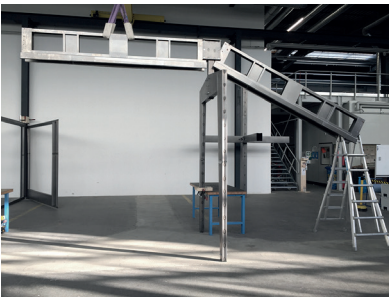
Fig. 258 Construcción colectiva del prototipo de la estructura de la Maison Tropicale de Jean Prouvé, Construction Cycles , 2021, Suiza.
