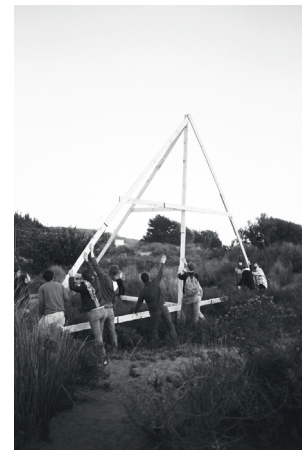
Fig.53 Construcción colectiva del gabarit de la cubierta, Open City Research Platform 2014, Chile.
