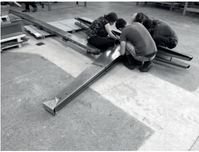
Fig.221 Desmontaje de las estructuras, Construction Cycles , 2020, Suiza.
