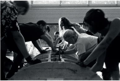
Fig. 60 Hormigonado experimental colectivo para una lámina fina, A Prototype Pavilion in Textile Reinforced Concrete , 2022, Suiza.
