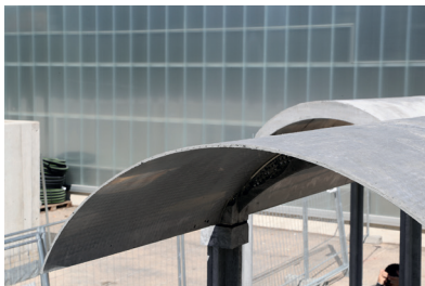
Fig. 249 Elementos en hormigón armado textil, cáscara de 9 mm de espesor, A Prototype Pavilion in Textile Reinforced Concrete , 2019, Suiza.
