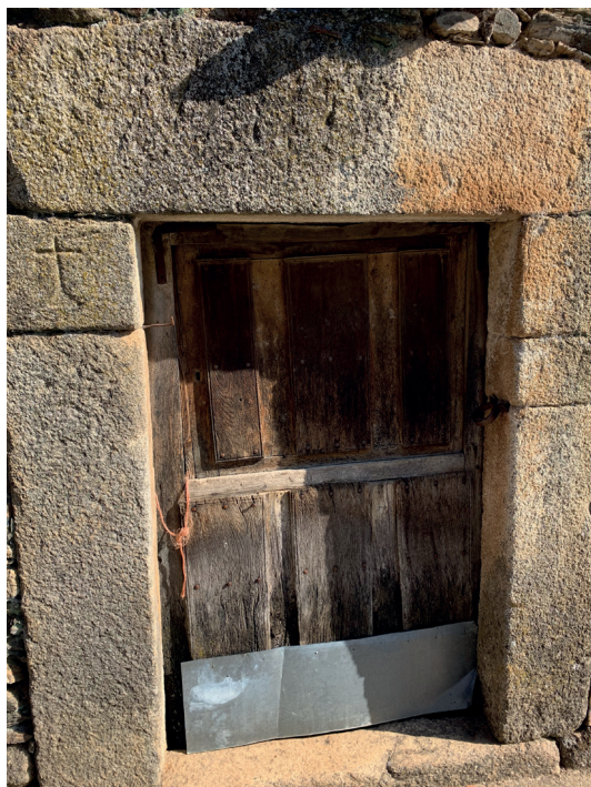
Fig. 3. Jambas de una puerta del Conjunto Histórico de Alcañices, con una curiosa herradura en la derecha.
