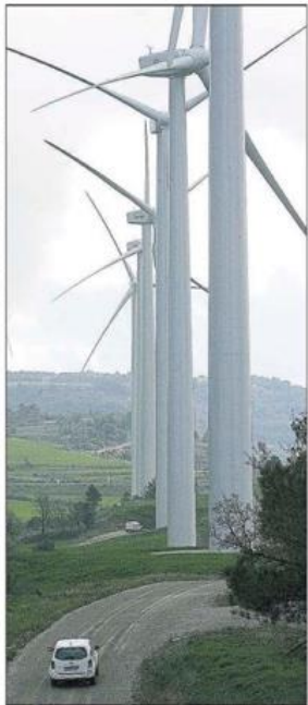
Parque eólico Serra del Tallat, en la comarca de Barberà, en Tarragona
