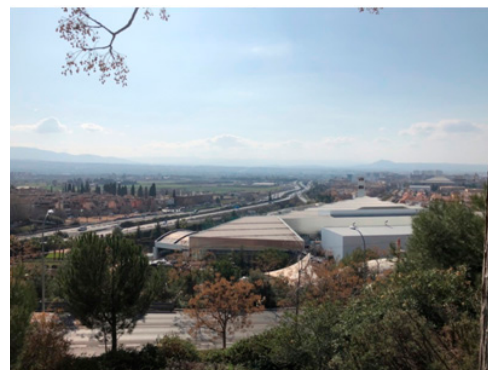
Cubiertas del centro comercial Serrallo. Fuente: elaboración propia
