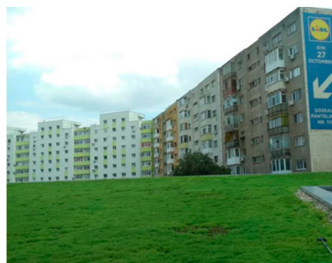
Cubierta vegetal en centro comercial Lidl (Naturvation, 2017k)
