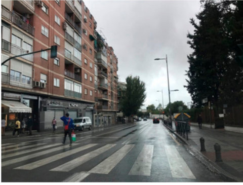
Río Beiro embovedado a su paso por la calle Ribera del Beiro. Fuente: elaboración propia
