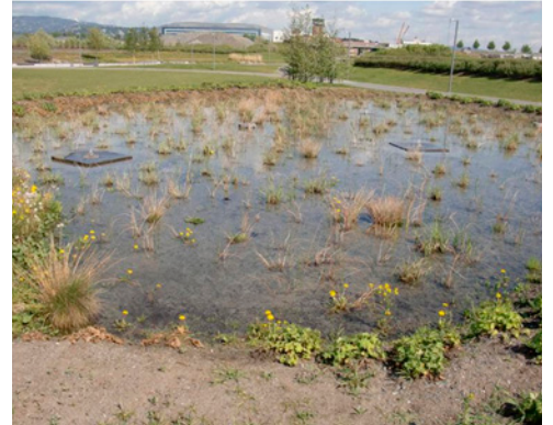
Sistema de gestión de aguas pluviales de Fornebu (Nilsen, 2018)
