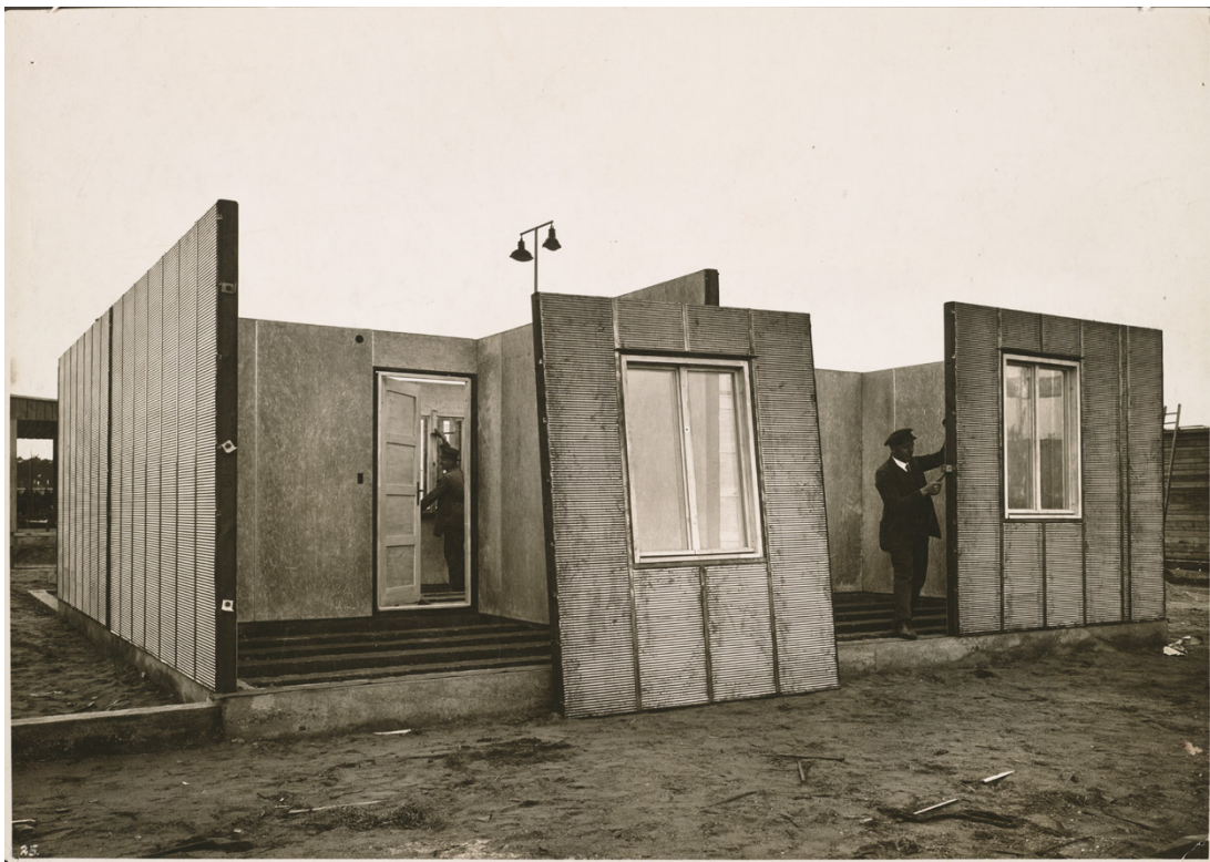
Figura 3. Prefabricated Copper Houses , 1931-1932: Construcción. Papel de gelatina de plata 16,5×24,4 cm.
