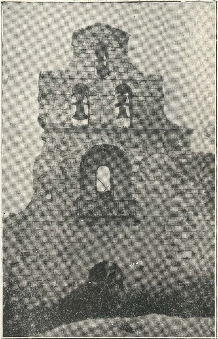
FACHADA PRINCIPAL EN LOS ULTIMOS BOMBARDEOS
