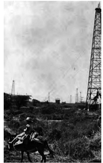
Fig. 2. Arriero delante de torres petroleras. Lagunillas, 1945. Fotografía publicada en El Faro , n. 73.
