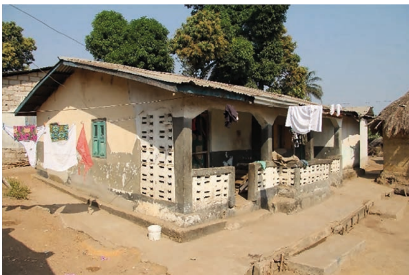
Viviendas en Makeni
