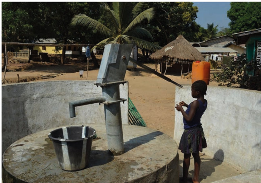
Pozo domiciliario tipo en Makeni
