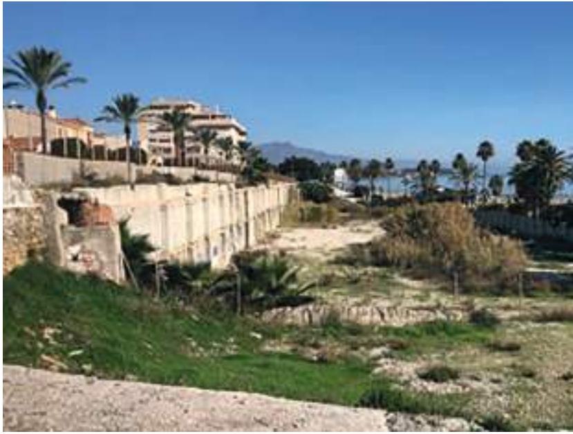
Vista desde el ángulo Oeste del solar objeto de la actuación
