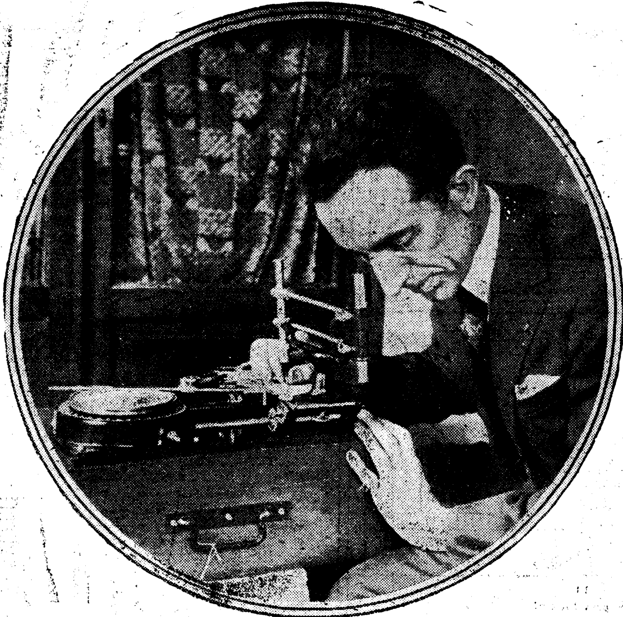
El Comandante Le Priour, con el aparato denominado «Navigator», que es invento, destinado a corregir en la navegación aérea los errores de orientación por causa de la influencia de los vientos. (Fot. Vidal.)
