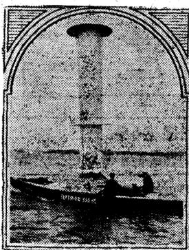
EL PRIMER YATE CON EL «FLETTNER-ROTOR» En Potsdam, en la Exposición de Sport Náutico, ha sido presentado el primer yate con el «Flettner-Rotor». El buque Rotor «Buckau» ha sido el que ha servido de base para la construcción del nuevo yate. Se trata de un balandro gigante, cuya vela ha sido sustituida por cilindros giratorios. Las pruebas han dado un resultado excelente. (Fot. Vidal.)
