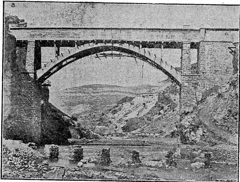
Aqueducto de hormigón armado sobre el Júcar
