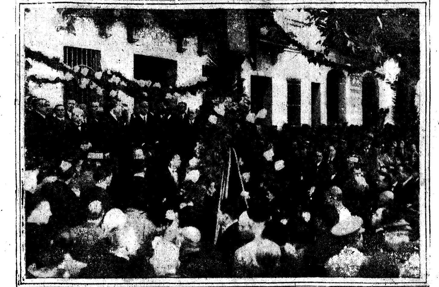
Bendición de la primera piedra de las obras de encauzamiento, a la que asistió el ministro de la Gobernación (Fot. Sagarra.)
