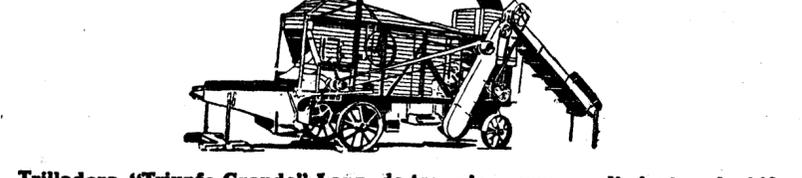
Trilladora "Triunfo Grande" Lanz, de tres pies, para rendimientos de 140 a 180 fanegas de trigo por día de diez horas de trabajo útil. Diámetro de cilindros, 510 mm.
