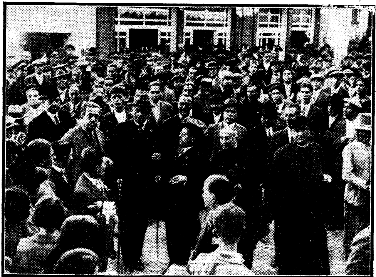
El general Primo de Rivera en el patio de la nueva casa cuartel de la Guardia civil de Constantina (Sevilla), que fué solemnemente inaugurada
