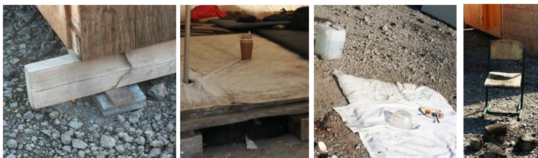
Figura III.24. De izquierda a derecha: apoyo de una de las construcciones en madera en «La Linière»; suelo de plásticos y colchonetas sobre base de palés; espacios exteriores en «La Linière», lugares improvisados para comer con colchonetas y mantas sobre la grava o sillas junto al fuego. Fuente propia, agosto 2016.
