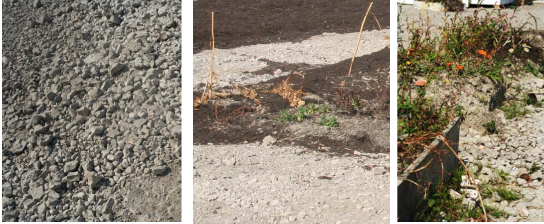
Figura III.21. La Linière en Grande-Synthe. A la izquierda suelo con grava de machaqueo, en el centro y a la derechas restos del huerto y de macetas de flores. Fuente propia, agosto 2016.
