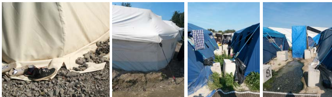
Figura III.23. A la izquierda La Linière, el peso de piedras y zapatos evita que se levante el zócalo de la tienda. Segunda imagen por la izquierda La Jungla de Calais, Family Tent sujeta con vientos y piquetas. Las tiendas en las dos imágenes de la derecha se anclan al suelo gracias a dados de hormigón y así, a pesar de la arena y el agua, se garantiza su estabilidad. Fuente propia, agosto 2016.
