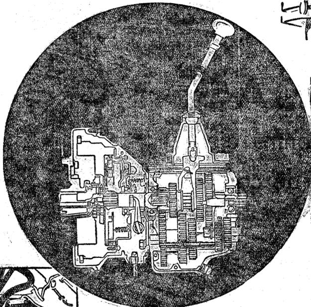
Con la transmisión de cuatro marchas, el nuevo camión FORD cuenta con la velocidad requerida para el transporte rápido y la potencia suficiente para salir de un bache a toda carga flexibilidad de adaptación de rapidez y fuerza a cada circunstancia
