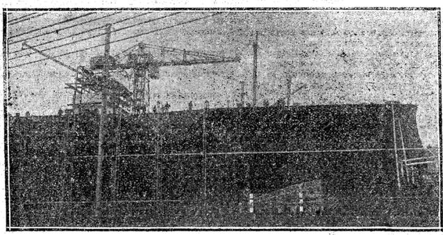
ACORAZADO "ESPAÑA".—El acorazado en grada. Fue colocada en quilla en 5 de Diciembre de 1910. Dimensiones principales: Estora entre perpendiculares, 132,55. Manga máxima, 24. Calado, 7,77. Desplazamiento, 15.700 toneladas.
