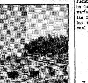
Figura 1. Pozo aéreo, del ingeniero Knapen, ya construido. Aparece en medio la masa central, provista de sifones aéreos.
