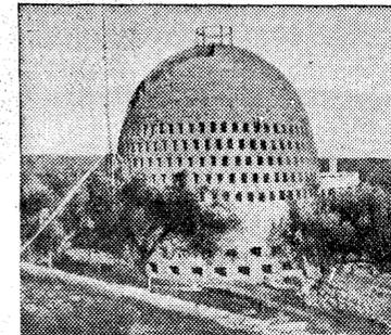
Figura 2. El pozo aéreo, del ingeniero Knapen, ya construido. Esta "colmena" liba el néctar precioso del vapor de agua de la atmósfera en las regiones áridas.
