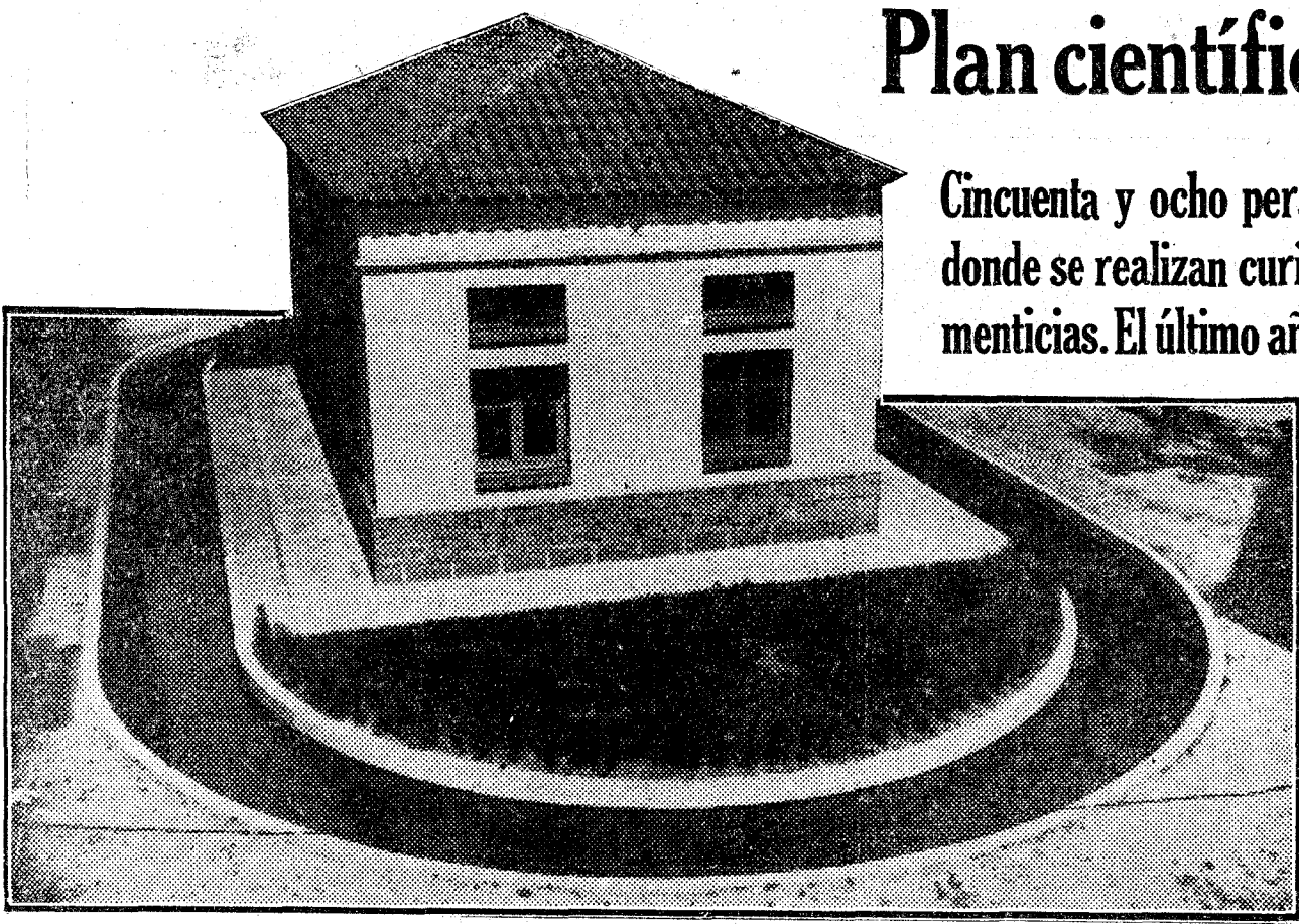
"Pabellón de la peste", desde donde a diario se avizora cualquier peligro que pueda amenazar a la ciudad, servicio montado en muy pocas de las más adelantadas poblaciones del mundo. El "Pabellón de la peste" está aislado por medio de un foso de agua
