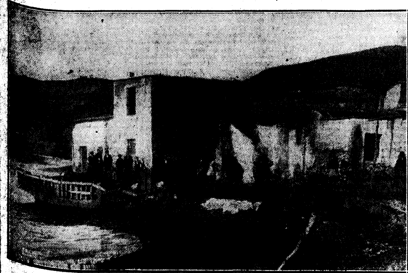
Una casa que resiste al mar, mediante un pequeño "dique" de vigas y piedras
