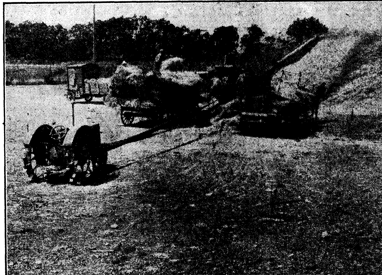
La trilla moderna no guarda semejanza con los sistemas tradicionales. Un equipo mecánico desgrana, limpia y distribuye automáticamente paja y grano, en cantidades considerables, con una cuadrilla reducida de trabajadores.
