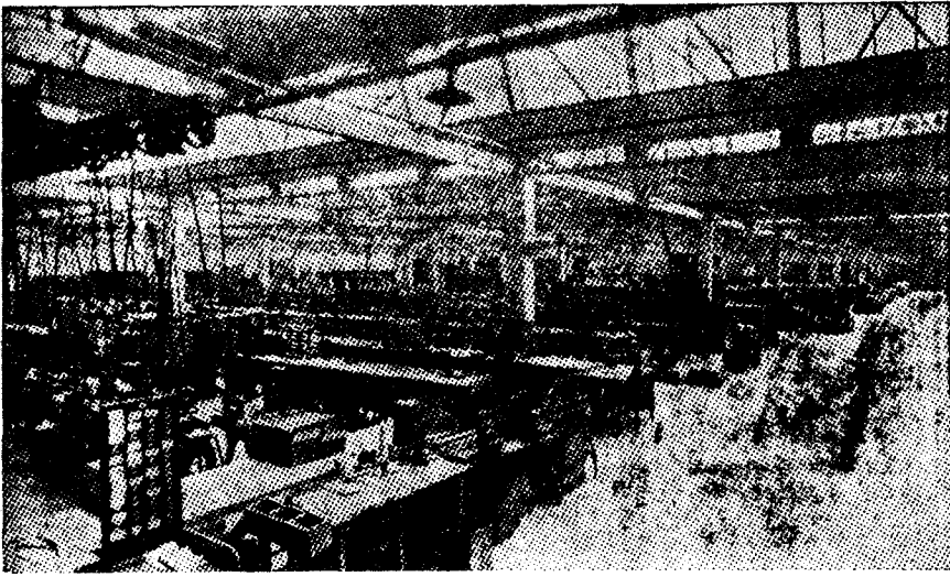
Esta enorme nave, llena de maquinaria, da idea de la importancia de la Fábrica Atwater Kent, que representa Auto-Elctricidad, calle del Prado, 27, cuya exposición está en E. Dato, 12.
