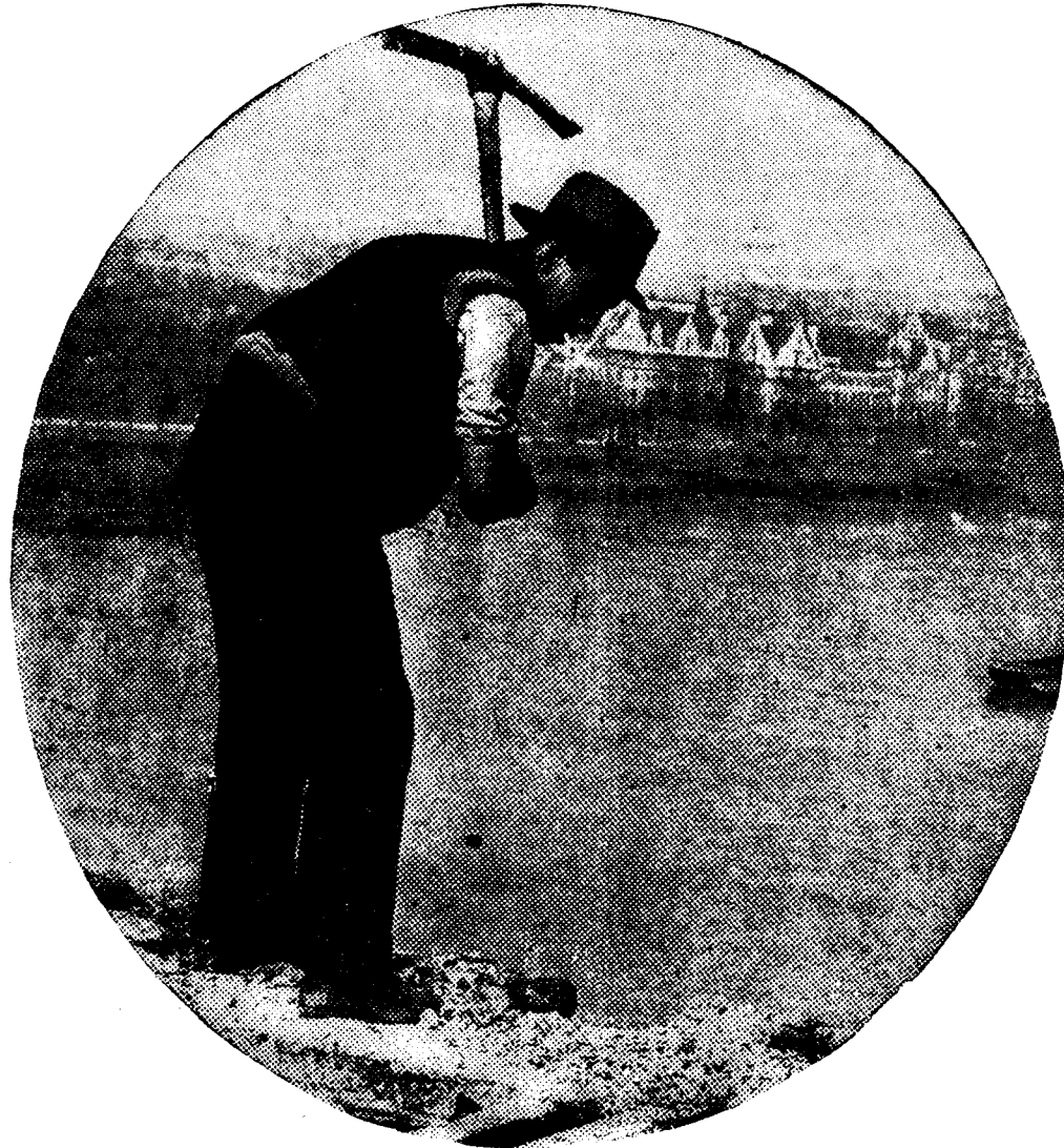
La vieja torre artillada de Waterloo, en el Estado de Gales, ha desaparecido después de haberse conservado a través de los siglos. Este obrero retira las últimas piedras
